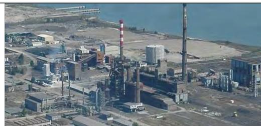
**Descrição Sumária** O conjunto é constituído pelo Alto Forno (18,480 m de altura útil e 6,5 m de diâmetro do cadinho), pela rampa de *skips* através da qual as matérias primas são introduzidas no forno, pela nave de sangria onde é feito o vazamento da gusa e da escória, pela sala de comando das operações de aquecimento e carregamento do forno, e pelo pote e dois ciclones onde se realiza a primeira fase do sistema de depuração de gás do Alto Forno.
