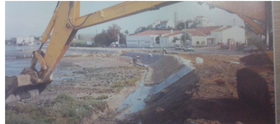
-Construção da frente ribeirinha da Ponte da Fraternidade- -Arrentela em colchões Reno (93)
