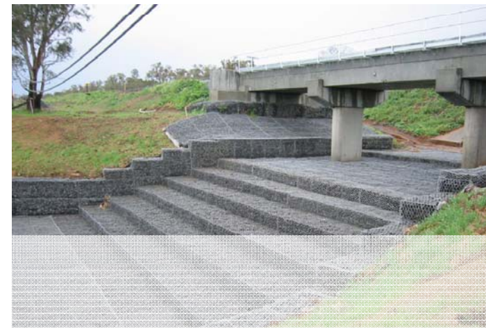
-Construção da frente ribeirinha da Ponte da Fraternidade- -Arrentela em colchões Reno (93)
