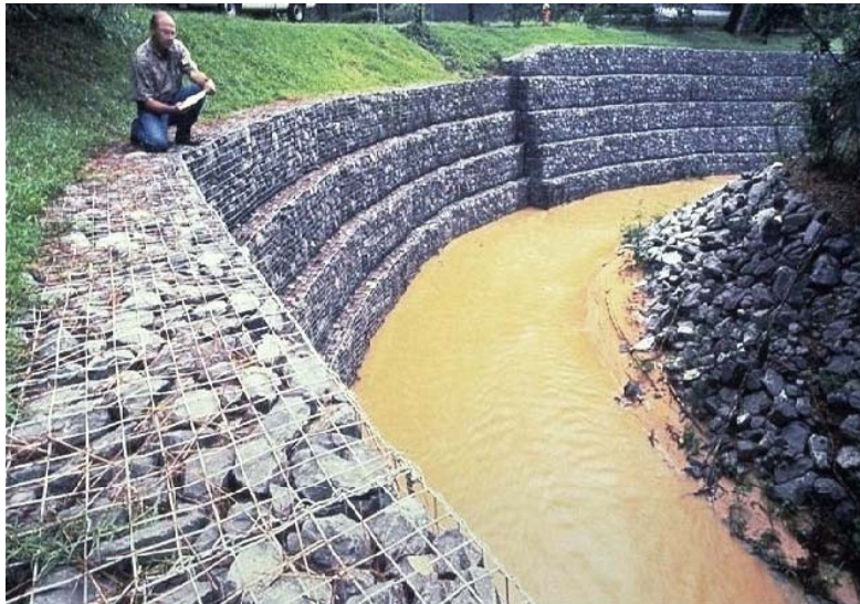
-Construção da frente ribeirinha da Ponte da Fraternidade- -Arrentela em colchões Reno (93)
