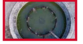
Disposto junto à casa da máquina, constitui o sistema de refrigeração para a água de circulação do condensador, que é arrefecida quando projetada pelas agulhetas e posta em contacto com o ar. Contém habitualmente 25 000 litros de água.
