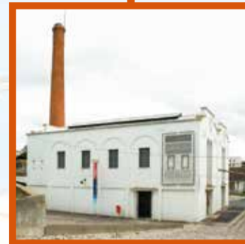
2 Edifício das Caldeiras Babcock & Wilcox
