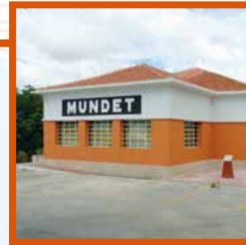
1 Edifício dos Serviços Centrais do Ecomuseu Municipal do Seixal
